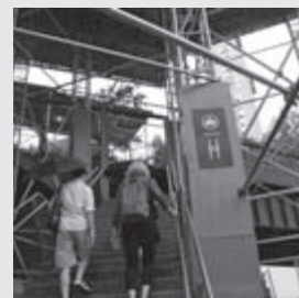
Výstup na High Line
